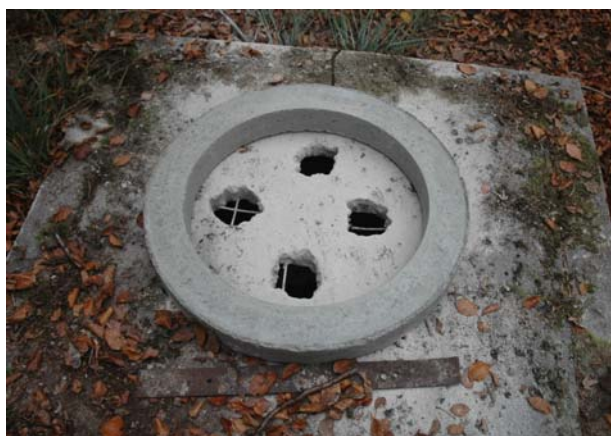
Abb. 4: Der aus Sicherheitsgründen mit einer Betonplatte verschlossene Bewetterungsschacht wurde teilweise wieder eröffnet. Bild: E. Müller
